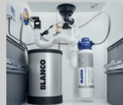
Die Smart-Armatur lässt sich nachträglich in bestehende Küchen einbauen. Titan-Boiler und Filter verstecken sich im Unterschrank.
